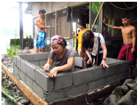
子ども用トイレ建設中の様子
